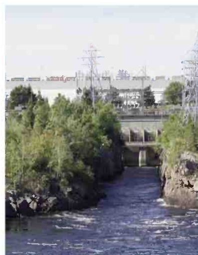
Photo du barrage McCormick, prise en septembre 2014 lors de la Tournée du Bureau sur la Côte-Nord. Érigé sur la Rivière Manicouagan, à Baie-Comeau, ce barrage est doublé d'une centrale hydroélectrique d'une puissance de 235 MW.
