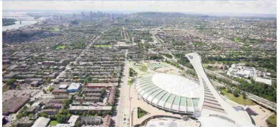
Stade olympique de Montréal/Photo Hydro-Québec ▲
